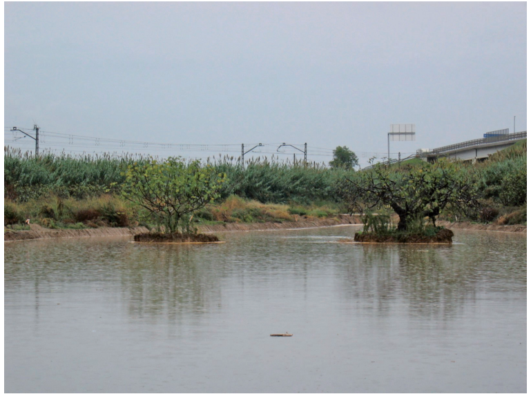
FIGURA 6. Bassa de laminació del torrent Fondo. Font: Arxiu CUADLL.
